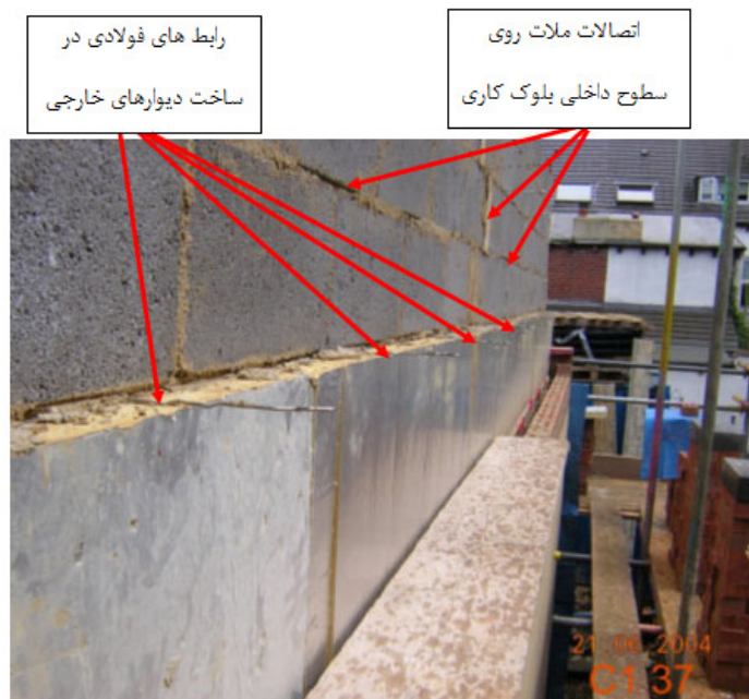
شکل ۵- عملکرد ملات به عنوان پل حرارتی
